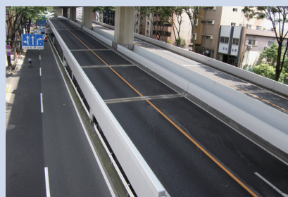
▲ 道路橋壁高欄の水掛かり防止対策
