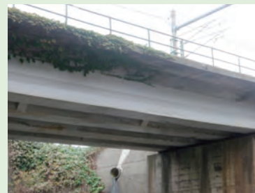
写真1 海岸沿いの橋梁の桁
