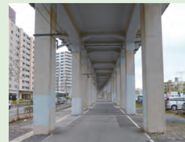
写真2 海岸に近い高架橋の橋脚
